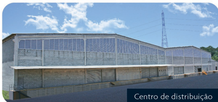
Centro de distribuição
